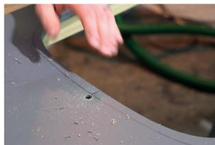
Danach setzen Sie die Messing-Spreizdübel ein. Anschließend wird das Spülbecken befestigt, indem die Dachschrauben durch die Befestigungsclips und Unterlegscheiben in den Messing-Spreizdübel platziert und verspreizt werden.
