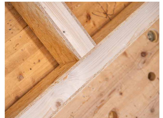
Die EGGER EcoBox in der Vorfertigung von Holzrahmenbauwänden.
