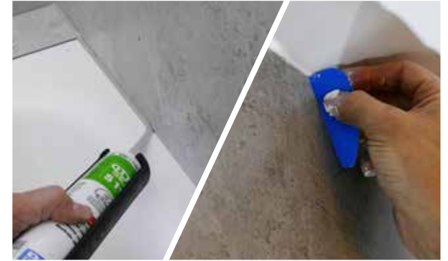
17. FUGEN MIT SILIKON ABDICHTEN UND SILIKON ABZIEHEN
