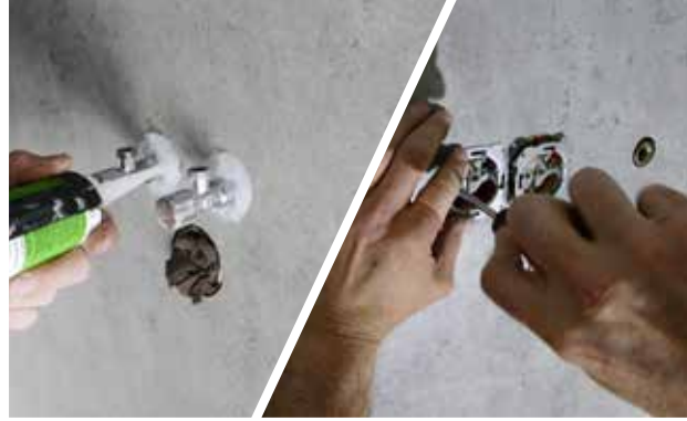
16. ÖFFNUNGEN MIT SILIKON AUSSPRITZEN UND ARMATUREN MONTIEREN
